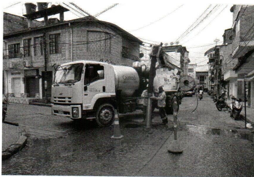
Mantenimientos del sistema de alcantarillado
