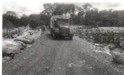
Foto 2: Apertura de vía 2
