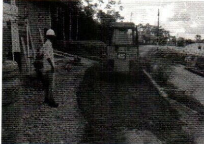
Foto 4: Mantenimiento de vía interna
